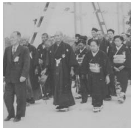
豊栄橋改修後の渡初め (昭和 28 年)
