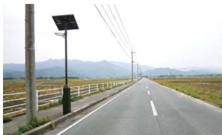
②LED照明灯(町道馬越俣瀬線)平成24年度、町道馬越俣瀬線に12基設置されました。
