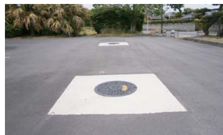
③FRP防火水槽(別府原)平成24年度、下之馬場、別府原、役所上、役所中に4基設置されました。
