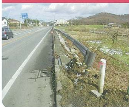
ガードレール・標識等の損傷
