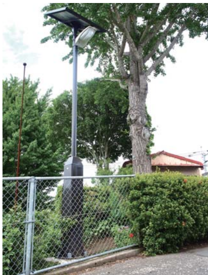
LED照明灯(高齢者福祉センター)
