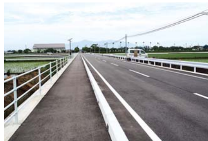
町道池之原永峯線改良舗装工事
