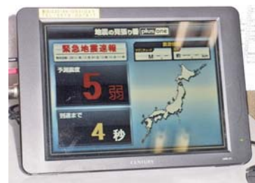
【柏原小学校に設置された緊急地震速報システム】
