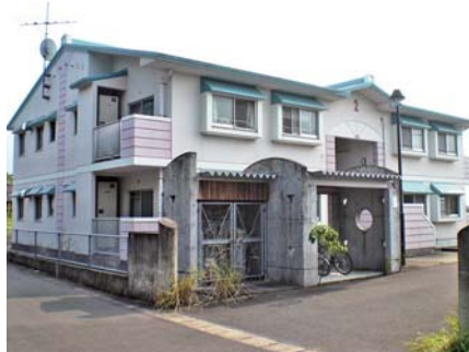
松原団地外観
