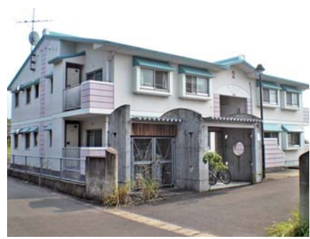
松原団地外観
