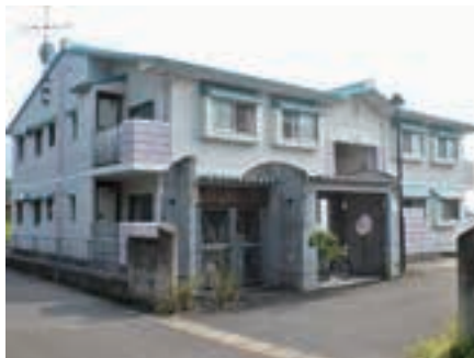
松原団地外観
