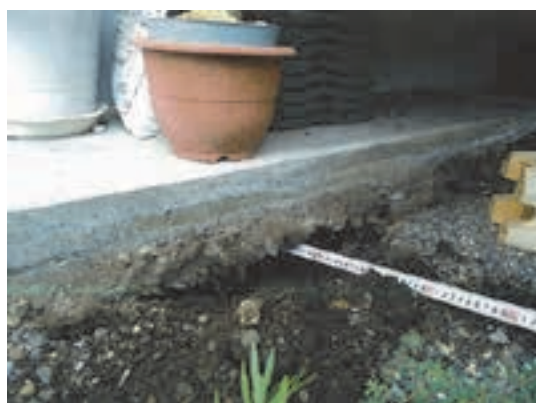
家屋基礎下の隙間【平成26年8月】
