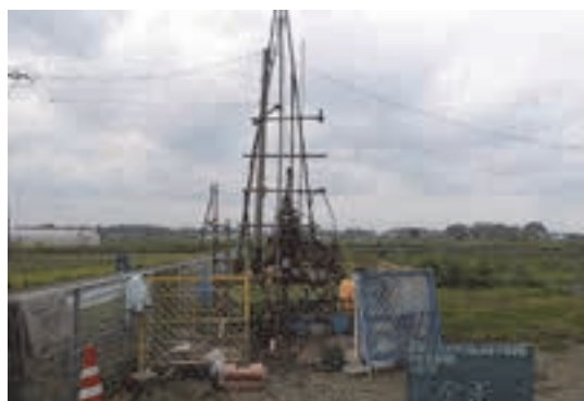
ボーリング作業の様子
