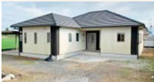
雪山住宅1号棟
