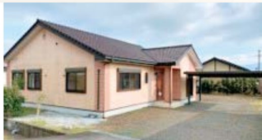
雪山住宅2号棟
