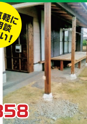
◀ 昨年施工したテラス
