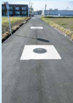
FRP 防火水槽 (池之原地区)
