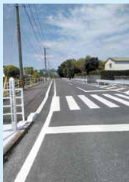
車道及び歩道の拡幅を行った町道豊栄馬越線
