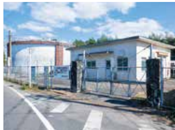
雪山水源地・配水池
