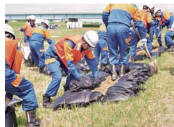
消防団による水防工法
