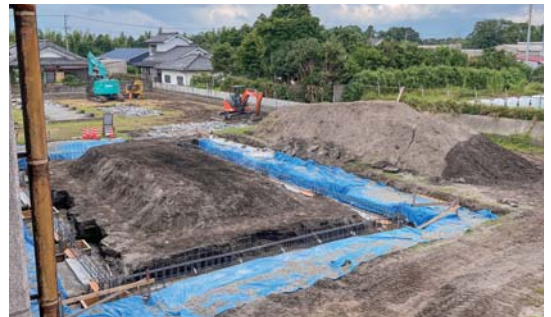
プール工事・自転車置場移設
