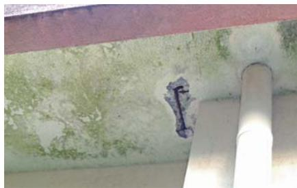
南西側軒裏の爆裂・塗装の剥がれ
