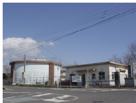
第1水源及び雪山配水池
