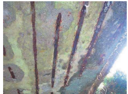
【健全性 II : 芝元橋】
