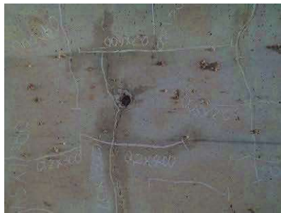
【健全性 II : 牧内橋】
