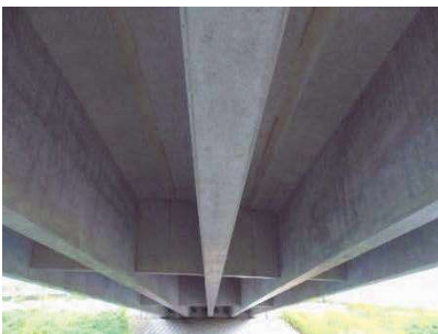
【健全性 I : 下大橋】
