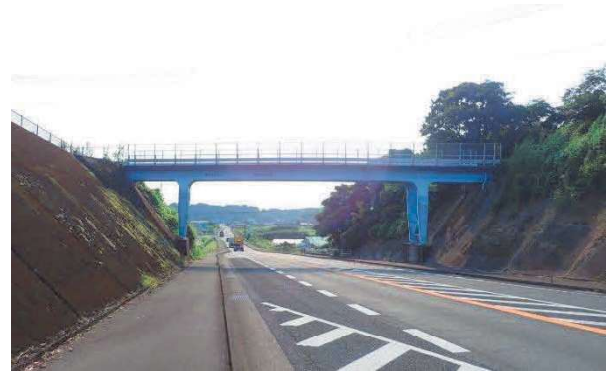
『東串良跨道橋』
