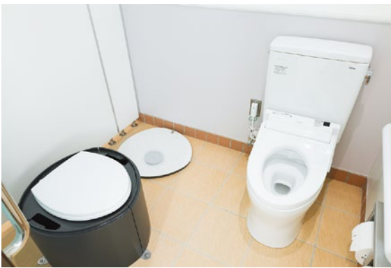
マンホールトイレ設置時
