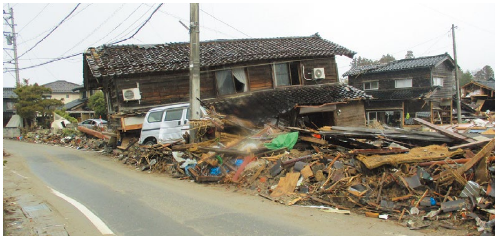
▲能登半島 震災状況
