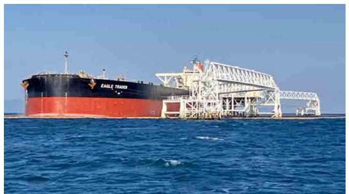
大型タンカーの着積状況
