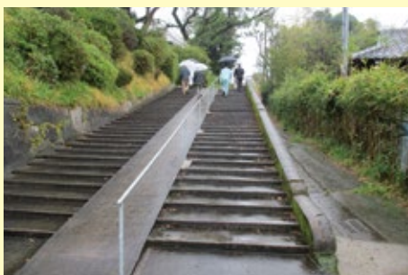
▲町有地（学校側の土地）を活用して道路の拡幅工事を計画
