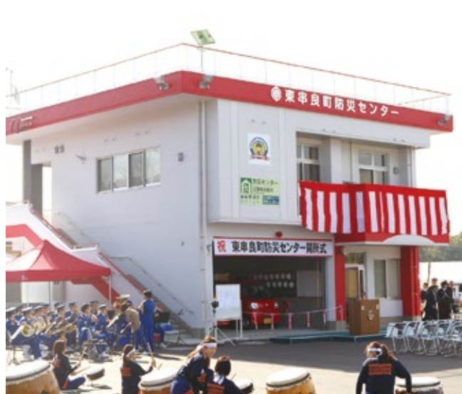
平成30年3月に完成した防災センター(安留地区)
