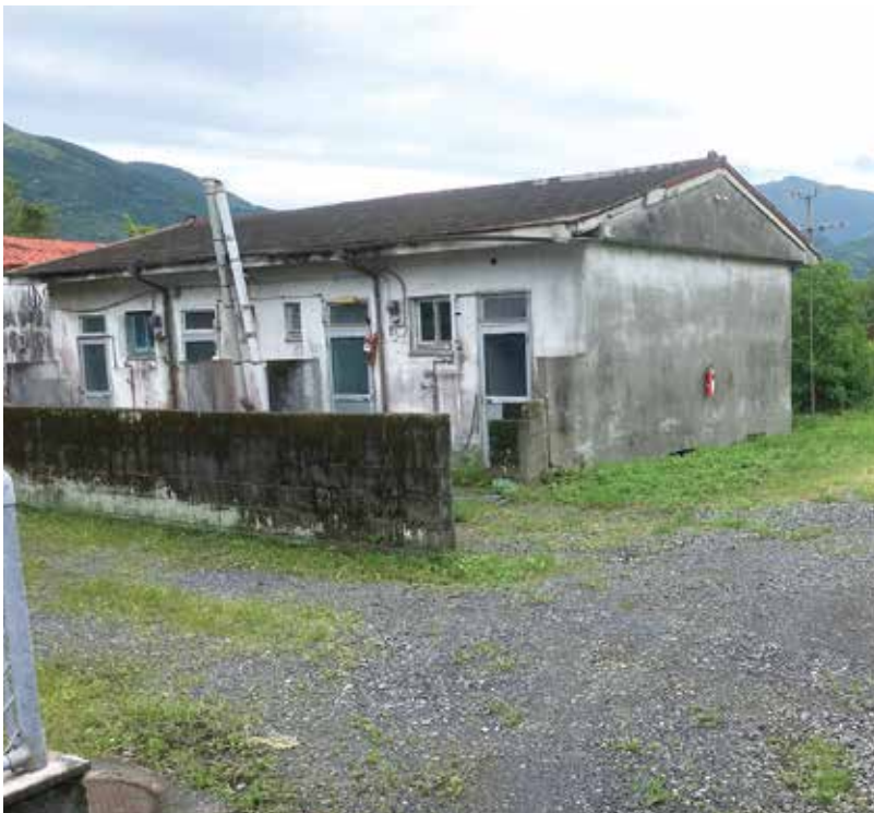
老朽化により住宅の解体が決まった柏原派出所団地
