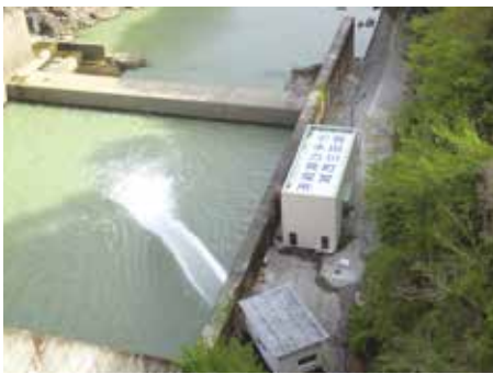
▲ダムの放流水を活用した発電所
