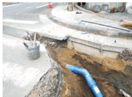
▲水道管の布設替え工事
