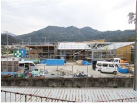
▲建設中の新中央公民館
