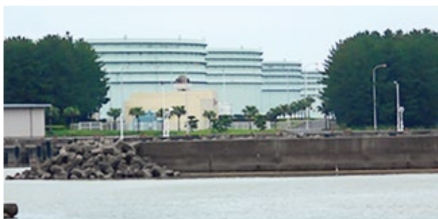
石油備蓄南側に防潮堤がないことが危惧される (志布志国家石油備蓄基地)
