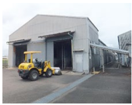
▲改修前の堆肥センター
