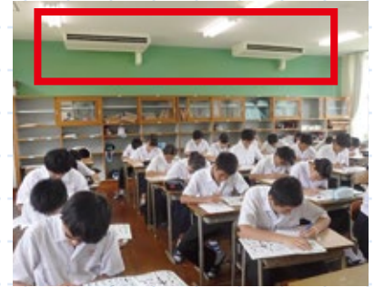
▲中学校エアコン設置
