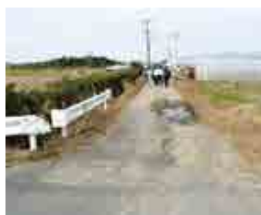
未舗装の安留地区農道
