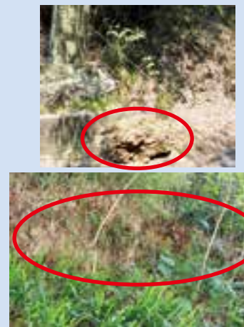
▲木の根などが露出し、がけ崩れの危険がある。(池之原小学校横の道路のり面)
