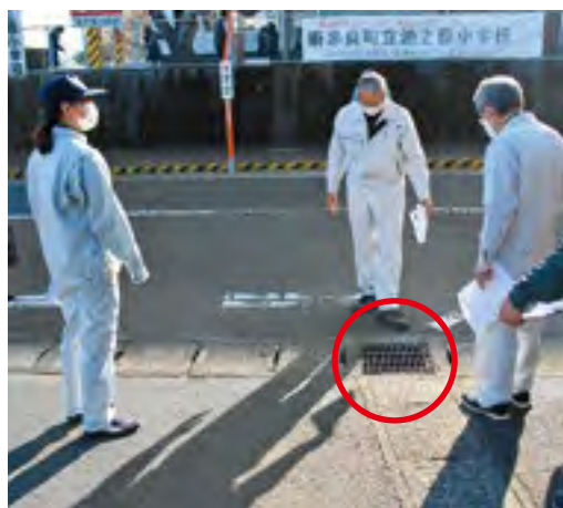
▲バス止めがされず、たびたびはずれて危険。 (池之原小学校前)
