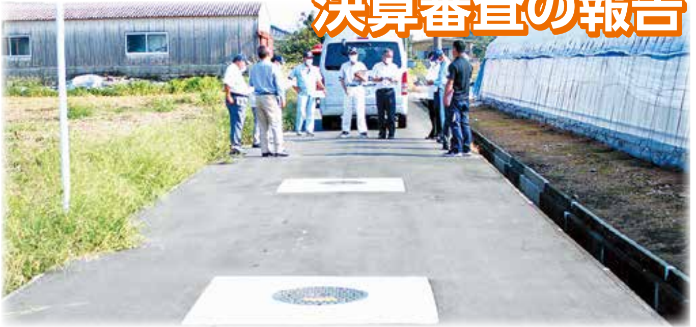
道路に埋設された防火水槽を調査
