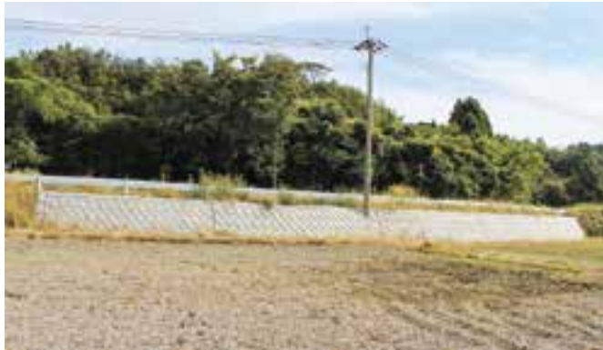
災害復旧工事(岩弘下中線) 1507万円
