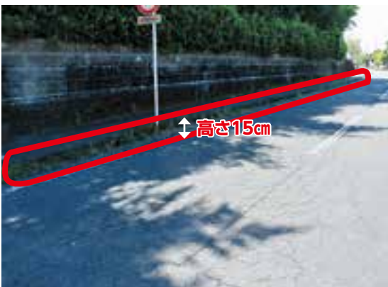
▲歩行者の安全対策が望まれる歩道。 (池之原小学校裏門) →9月議会で、 ポストコーン を設置するための 予算を決めました。
