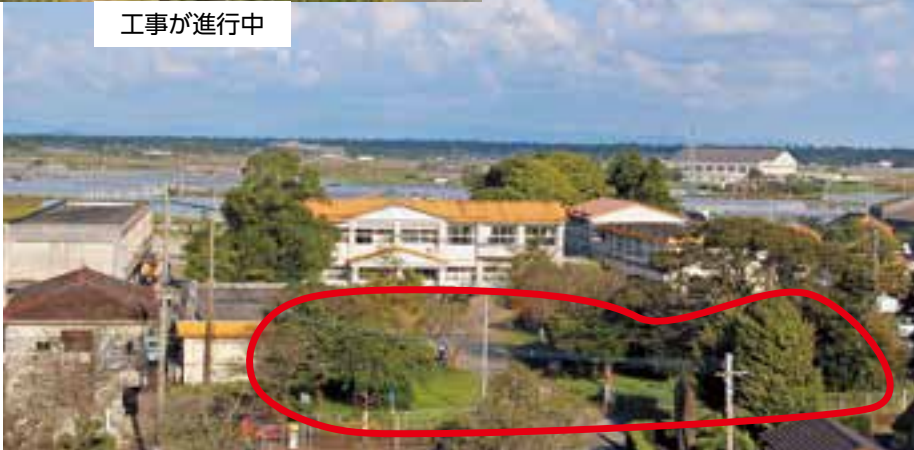
赤色で囲んでいる部分を整備 (着工前)
