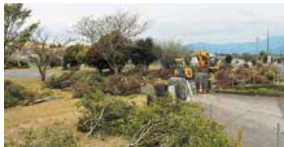
工事が進行中
