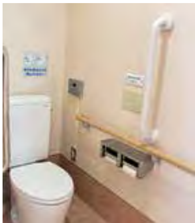
中学校トイレ改修工事 2385万円
