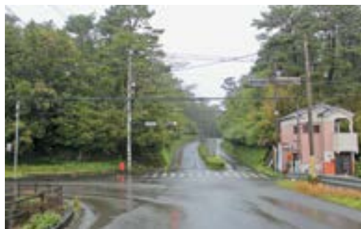
柏原地区に防潮堤を望む
