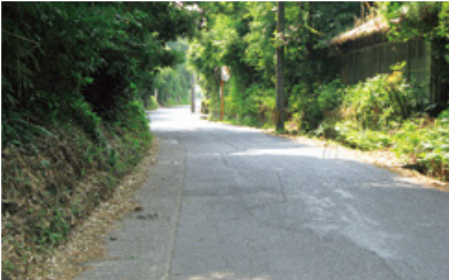
早期の道路拡幅を望む（溜水地区）
