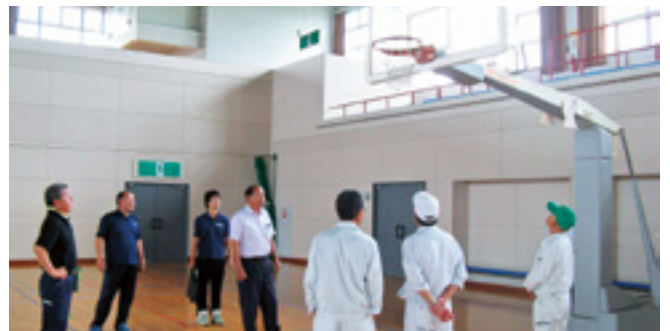
亀裂し修理が必要なバスケットゴール(町体育館)
