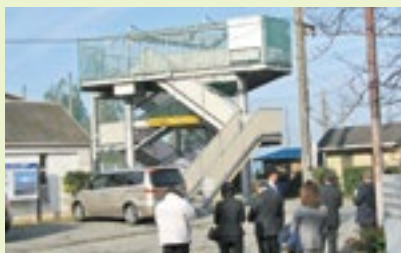
津波避難施設を視察
