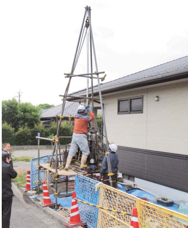
地盤をボーリング調査（にぎやかタウン雪山）
