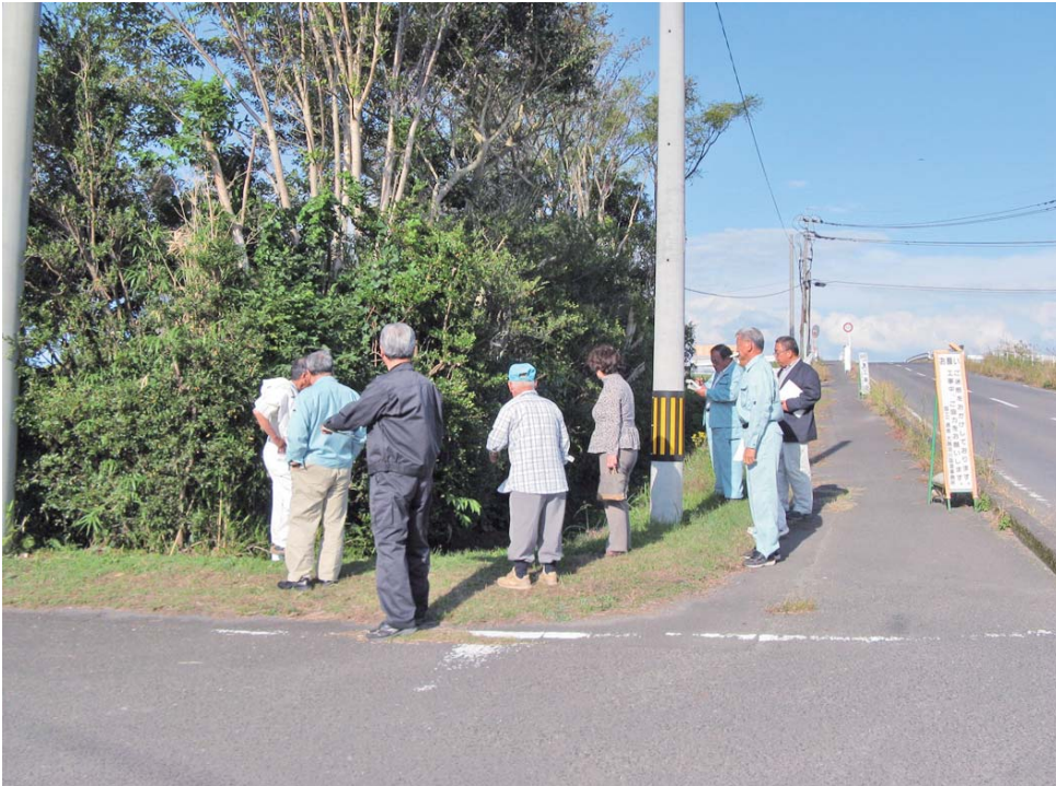
道路下の排水溝が詰まりやすく冠水する（俣瀬地区）
