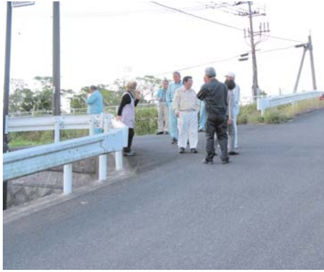
勾配が危険な交差点（俣瀬地区）
