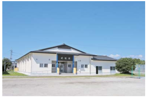
新築された武道館（中学校）
