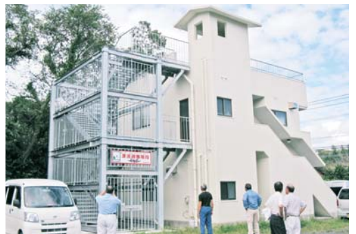
唐仁消防車庫に設置した津波避難階段
