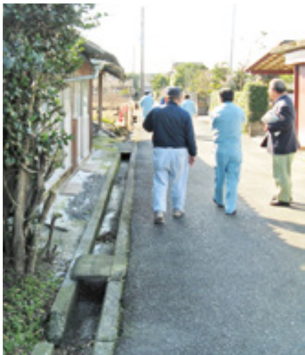
▲排水路に蓋があり掃除ができないため詰まっている。夏など蚊がわき異臭がする（豊栄地区）
