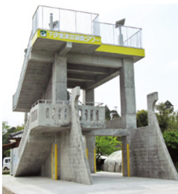
◆下伊倉地区津波避難タワー 平成 28 年 3 月 25 日完成 高さ 8m・屋上は面積約50㎡・避難対象人数約100人、防災倉庫があり発電機や毛布等を備蓄している。
