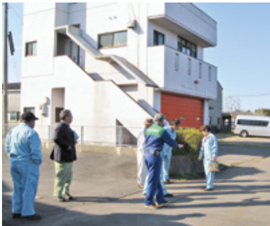
▲大雨時住宅から水がきて消防車庫前の道路が冠水する。道路が沈下しているようで、排水路の改善が必要である（別府原消防分団前）
