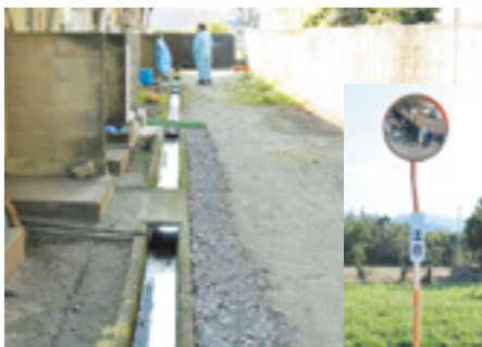
▲排水路が用をなしていない。大きくするなど改善の必要がある。また出入口のカーブミラーの向きがあていない（別府原団地）
