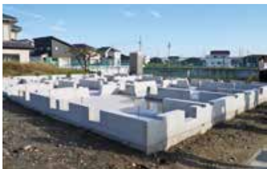
移転先の基礎は通常の基礎よりも頑丈に造られる
