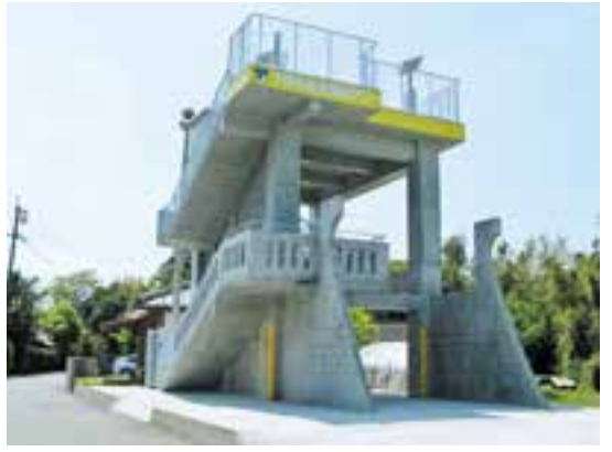
県内自治体で初めて建設された 津波避難タワー（下伊倉）
