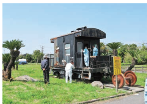
腐食のため撤去される客車（鉄道記念公園）
