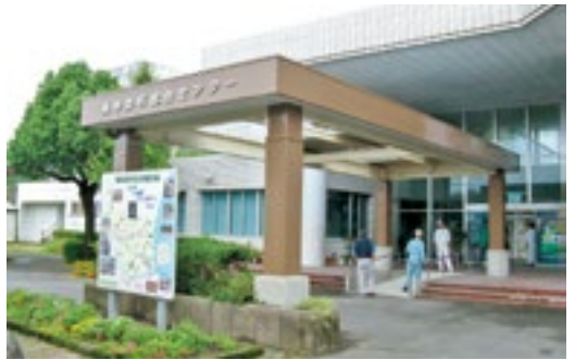
改修した総合センター玄関ポーチ
