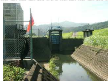
①肝属川堤防横ポンプ施設
