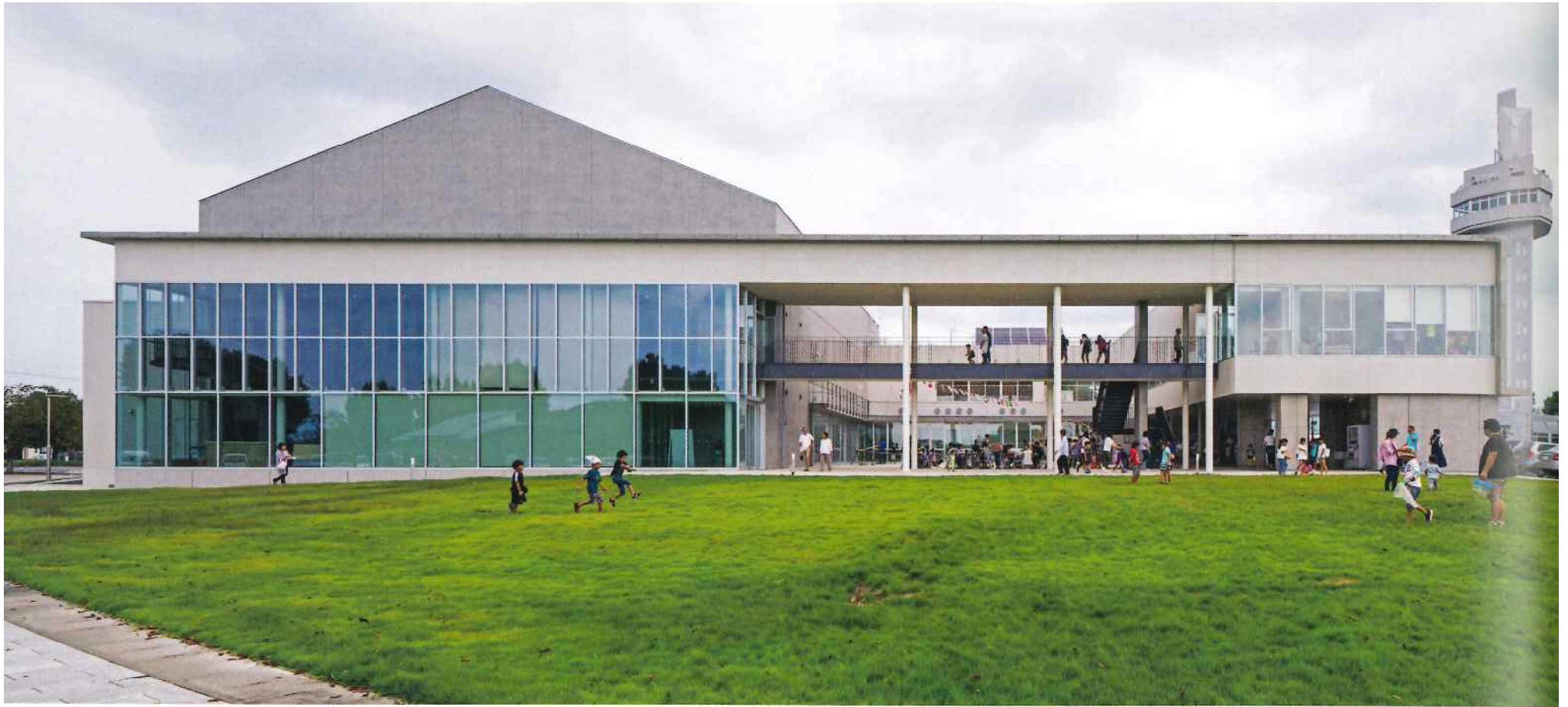
外観（「近代建築2018.10」）
