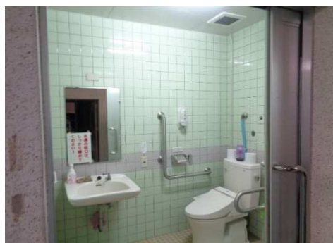
⑤男女トイレ:男女のトイレ間に間仕切壁なし(音漏れ) ⑥身体障がい者用トイレ:換気性能の低下(臭気あり)
