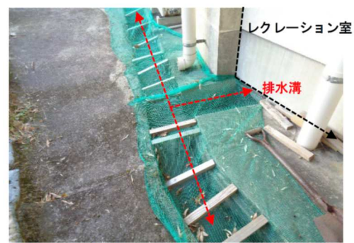
⑩南側建物廻り:排水溝のつまり対策・過去に陥没あり
