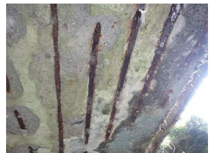
【健全性Ⅱ：芝元橋】
