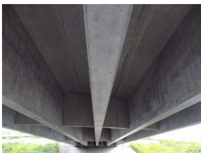
【健全性Ⅰ：下大橋】
