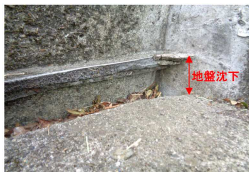
⑥北西側建物廻り:地盤沈下
