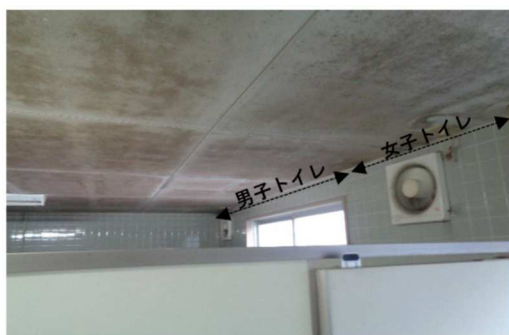
⑤男女トイレ:男女のトイレ間に間仕切壁なし(音漏れ) ⑥身体障がい者用トイレ:換気性能の低下(臭気あり)
