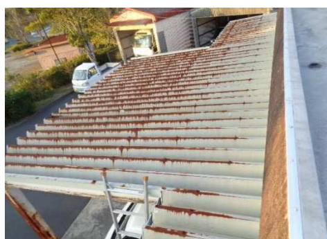
④北西側庇屋根:発錆
