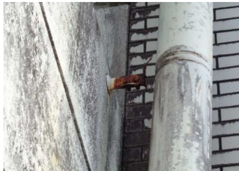
⑧西側縦樋支持金物:破損
