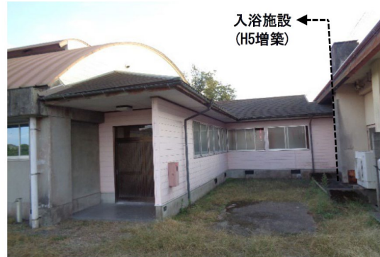
②入浴施設(H5 増築):未修繕箇所多数
