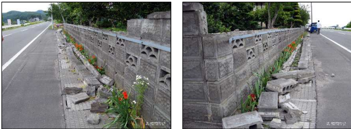
図 3-2 地震により倒壊したブロック塀
